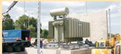
Kleine Bilder + Bild unten: Anlieferung und Montage der Großtransformatoren für das neue Umspannwerk Gera-Nord
