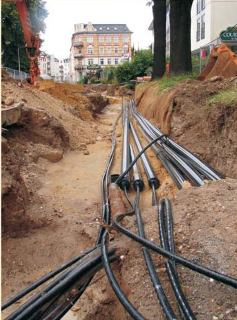
Bild oben: Komplette Erneuerung der Versorgungsleitungen in der Gutenbergsstraße im Zuge des Stadtbahnbaus
