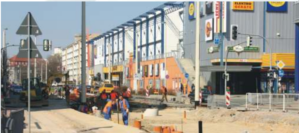
Stadtbahnlinie 1 - Neue Versorgungsleitungen für die Geraer Reichsstraße
