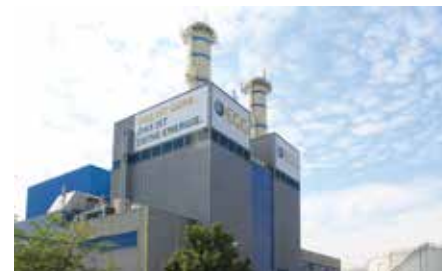
Seit März 2020 laufen die Rückbauarbeiten der EGG-Kraftwerke Gera-Nord und HW Süd
