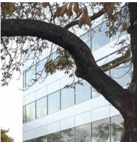
Wird mit Strom und Fernwärme der EGG versorgt: das neue Gebäude der Christlichen Gemeinschaftsschule in Gera gegenüber dem Hauptbahnhof
