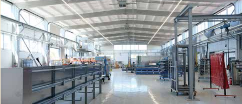
Nachhaltige Sanierung: Aus einer stillgelegten Halle wurde eine moderne, komplett renovierte Produktionsstätte der EMK Allstedt GmbH – die Biomethan-Lieferung für das neu errichtete BHKW erfolgt durch die EGG.
